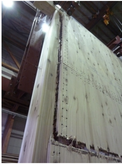
写真11 No.③の破壊（柱の割裂）
