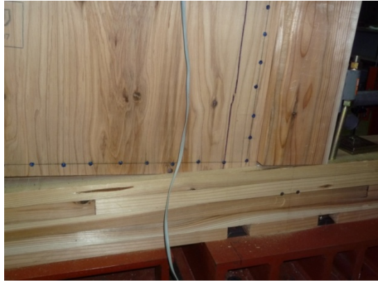
写真15 No.⑧の破壊(合板の土台へのめり込み)
