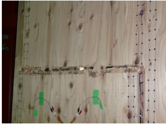
写真10 No.③の破壊（合板のせん断破壊）
