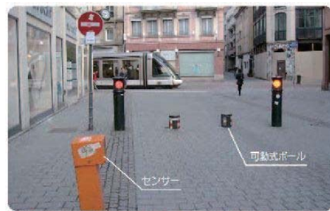
許可車のみ流入可能な通行止め (フランス・ストラスブール)
