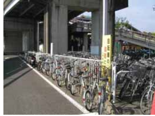
自転車駐車場の整備 （南口）
