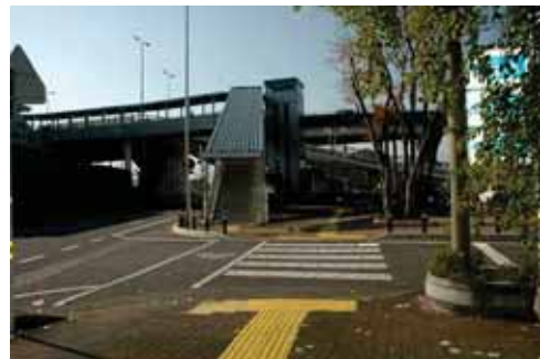
<整備後(JR西岐阜駅周辺)>
