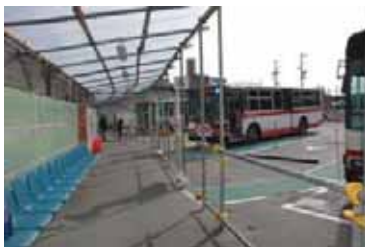
現在の仮設待合施設
