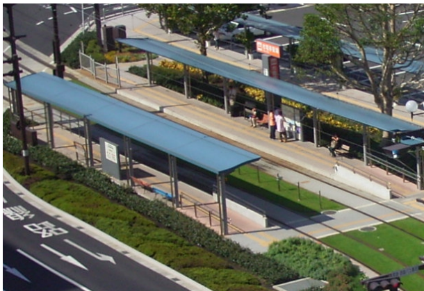
電停への上屋設置（鹿児島中央駅前）
