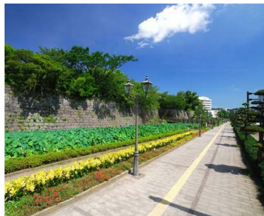
道路のバリアフリー化・電線類の地中化 (歴史と文化の道)
