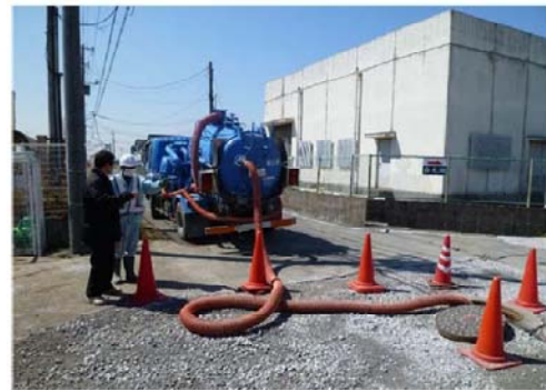
汚泥吸引車による吸引状況
