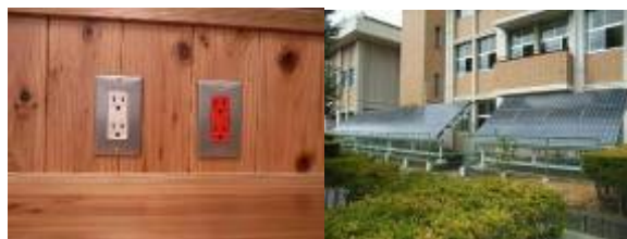
太陽光発電コンセント(赤)(今町小) / グラウンドから見える太陽光発電設備(南越小)
