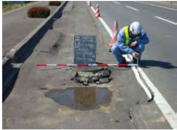
人孔突出、路面異常
