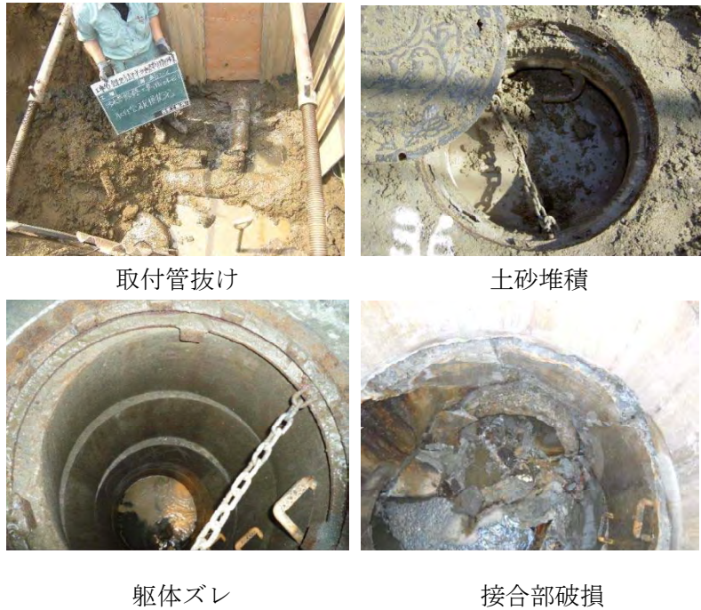
写真 I-1-3 周辺地盤の液状化による管路施設の被害状況（千葉市）
