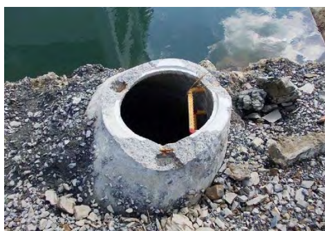
宮城県女川町(蓋の流出)
