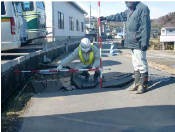
人孔突出、路面異常
