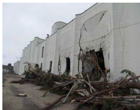
漂流物による建築物への直接被害
