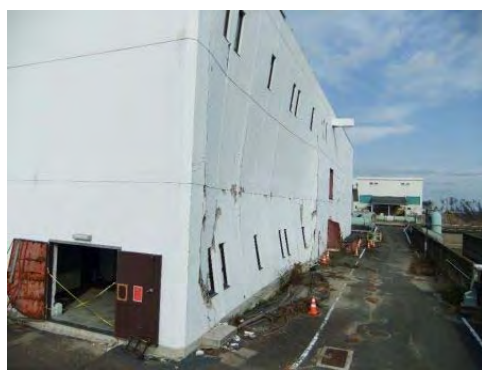
波圧による津波浸入方向の壁面被害
