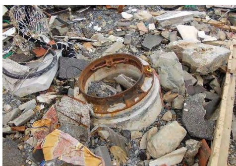
宮城県女川町(蓋の流出)
