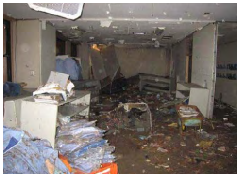
浸水による室内設備の水没被害
