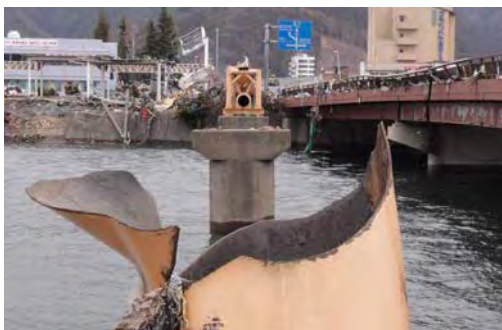
写真I-1-7 岩手県釜石市 矢ノ浦水管橋被害状況
