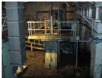
機械・電気設備水没、全機能停止 (自動除塵機)
