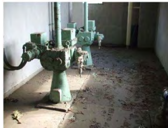
流入ゲート開閉操作器の電気設備が浸水、全機能停止 (流入きよ)
