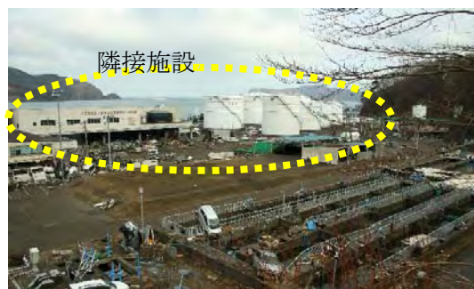
(写真奥が津波浸入方向：隣接施設有り) 写真 I-1-16 大平下水処理場
