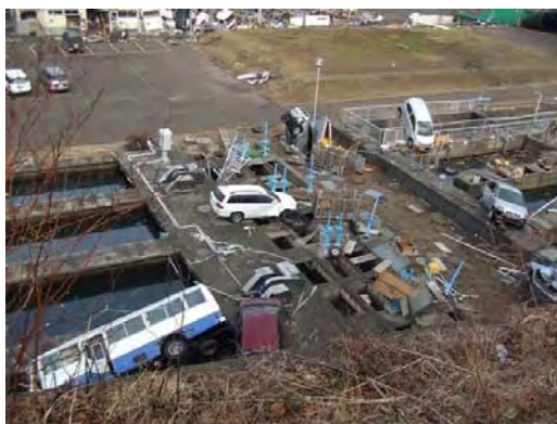
(水処理施設への車両浸入)
