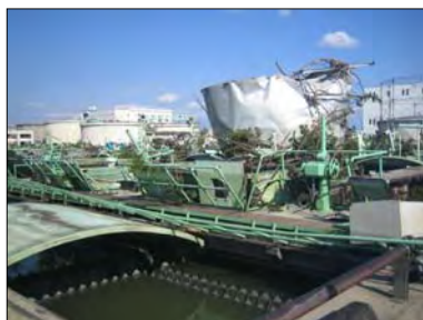
最初沈殿池にのりあげたガスタンク
