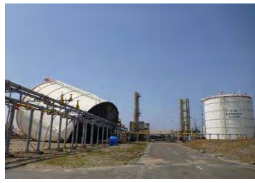
転倒したガスタンク
