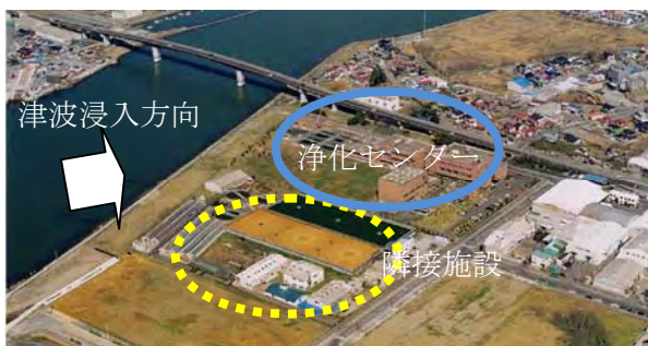
(津波浸入方向に隣接施設有り) 写真 I-1-15 石巻東部浄化センター
