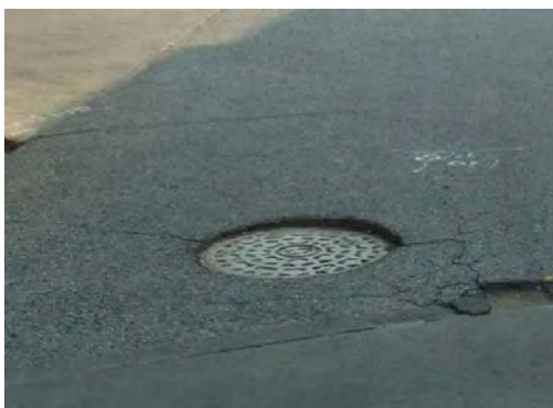
写真 I-1-9 人孔沈下被害例（Bタイプ）
