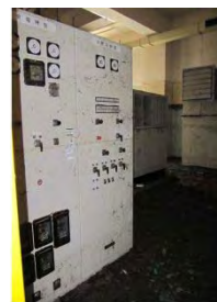
発電機及び発電機盤他水没、全機能停止
