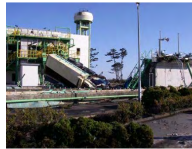
漂流車両による流入ゲート損傷
