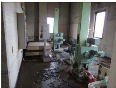
流入ゲート、操作盤浸水
