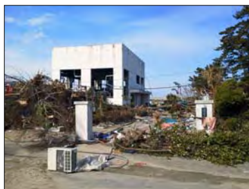
ポンプ場入口フェンス流出
