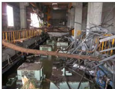
送風機施設への流木等の浸入
