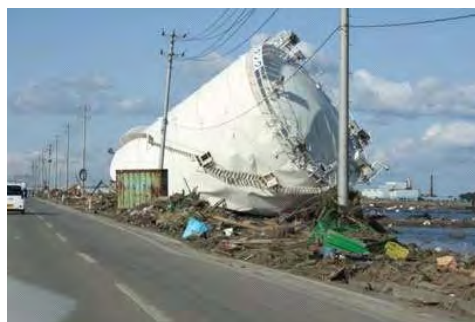
県南浄化センター（ガスタンクの流出）
