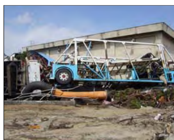
ポンプ場南東部 車両漂流物
