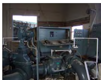
高圧受電盤他転倒
