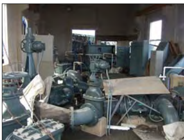
ポンプ場内部
