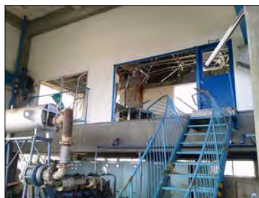
2階操作室内設備の破損・流出
