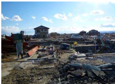
ポンプ場全景
