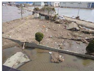
津波による建屋損傷、周囲浸水
