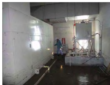
自家発電施設浸水
