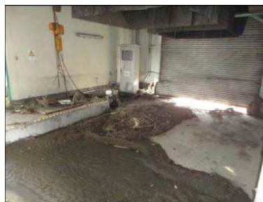
ホッパー室津波により操作盤浸水
