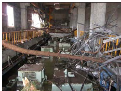
(送風機棟への流木浸入)
