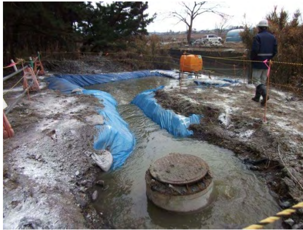
仮設沈殿状況
