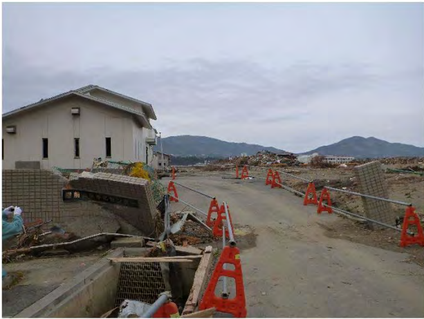
被災後の浄化センター
