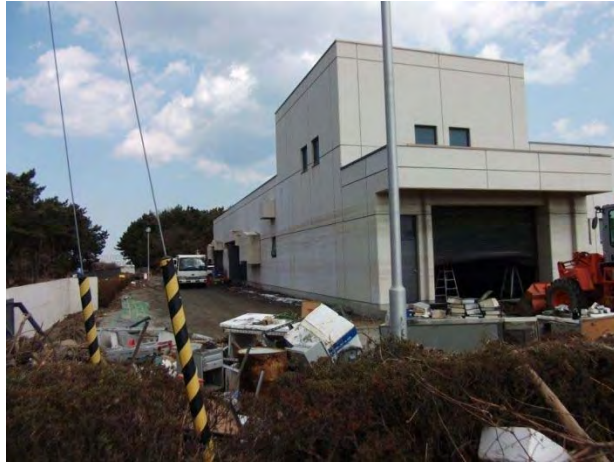
馬淵川流域 八戸市汚水中継ポンプ場外観
