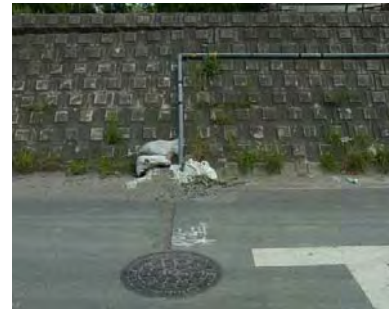
露出配管から下流人孔への流入
