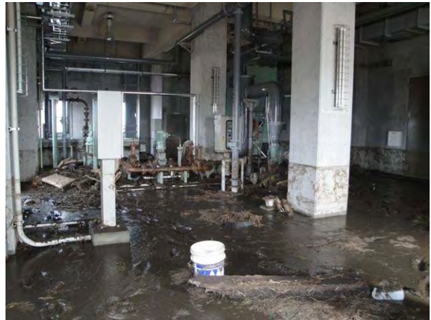
施設内浸水被害状況
