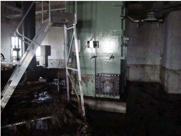
施設内の浸水被害状況
