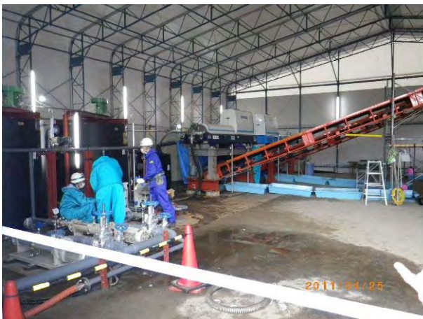
仮設脱水機の設置状況
