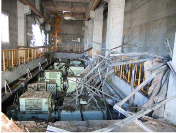
送風機棟内の被災状況
