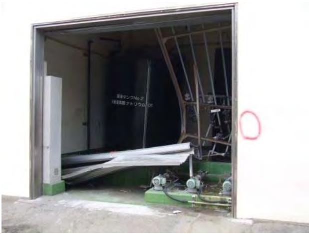
津波により建屋扉の損壊
