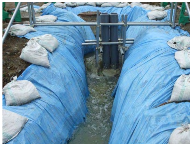
消毒放流状況
