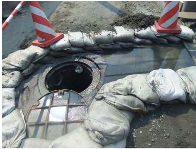
土のうを用いた近傍側溝への消毒放流状況その2（多賀城市）
