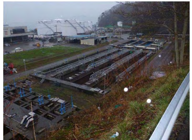
瓦礫撤去後の大平下水処理場の水処理施設
