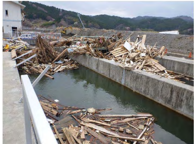
処理施設への瓦礫侵入
