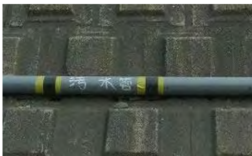
露出配管の設置状況
