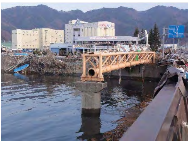
損壊した水管橋
