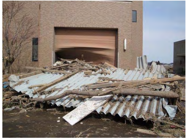
損壊した建屋扉
