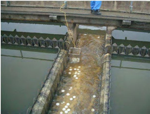
初期における固形塩素での消毒状況
