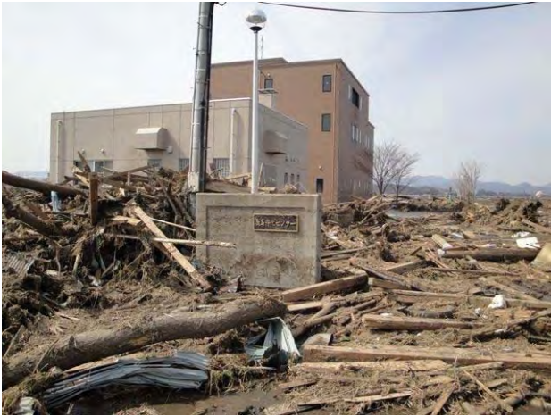
被災後の浄化センター
