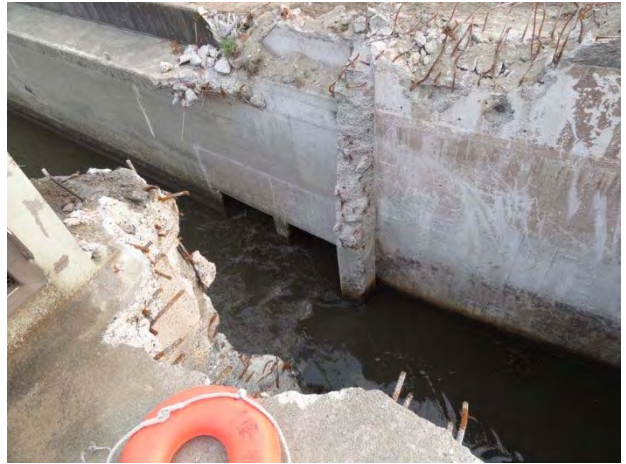
躯体を取り壊しての放流ゲート開放状況
