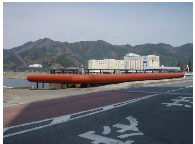
水管橋の仮設配管設置
