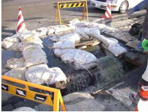
土のうを用いた近傍側溝への消毒放流状況その1（多賀城市）
