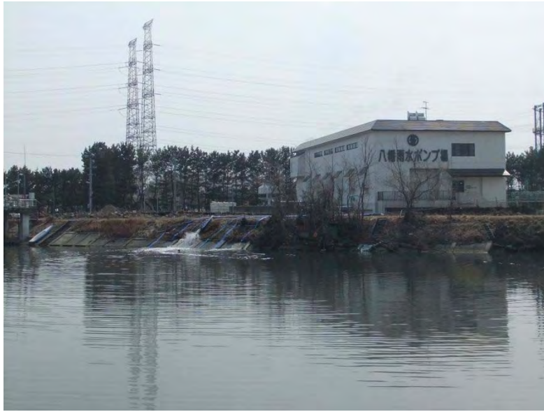
仮設ポンプによる排水
