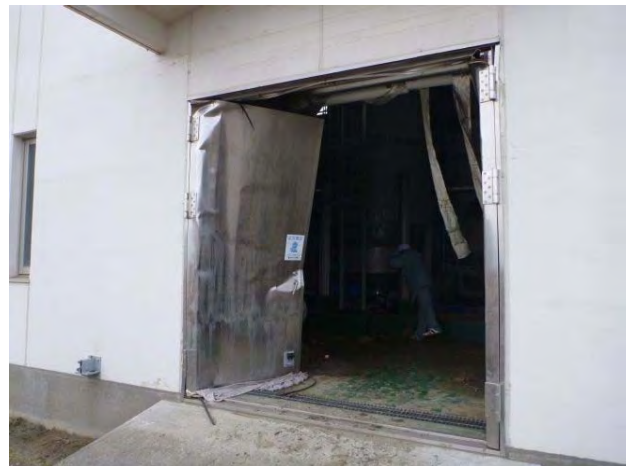
津波により破壊されたドア
