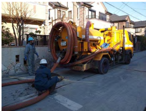
人孔内の堆積土砂の撤去
