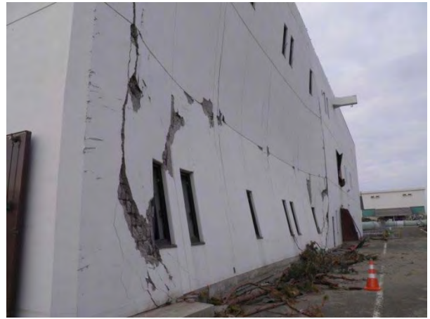
第3ポンプ室の津波による外壁の被災状況
