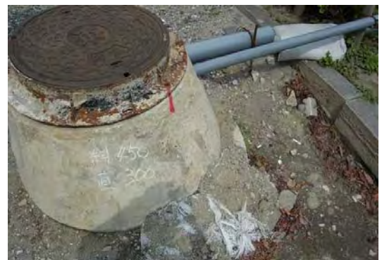
人孔内への仮設ポンプ設置及び露出仮配管
