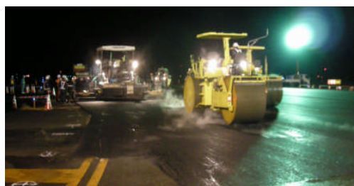
既存空港の誘導路の舗装改良
