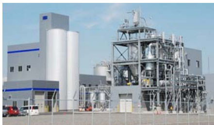
バイオエタノール技術実証プラント オエノンホールディングス(株)苫小牧工場
