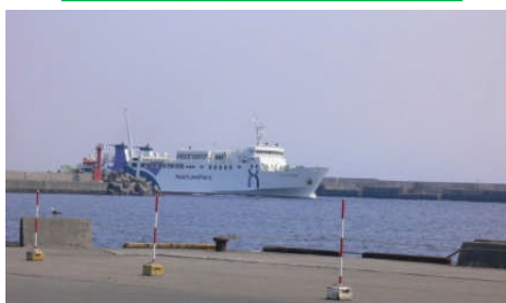
香深港(礼文島)の防波堤整備 礼文島を本土(稚内)や利尻島と結ぶフェリー航路
