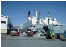
古紙等を扱うRORO船岸壁の老朽化対策(苫小牧港)
