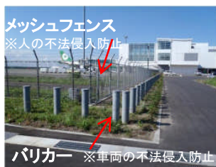
不法侵入対策 (新千歳空港 国際線)
