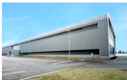
石狩データセンターさくらインターネット(株)
