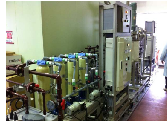
図2. 設計・作製した焼却灰除染小型プラントの外観図
