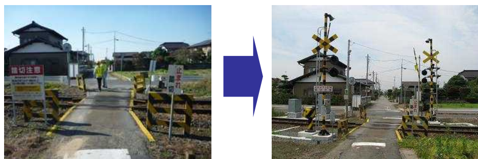
図1：踏切遮断機・警報機の整備
