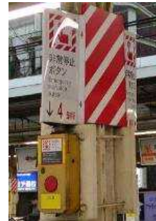
図3: 非常停止押しボタン
