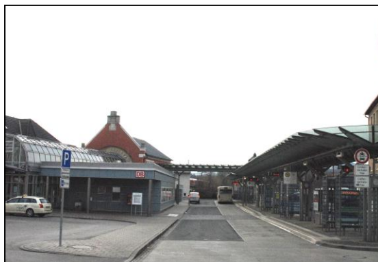
写真 4-3 ザールフェルト駅前広場
