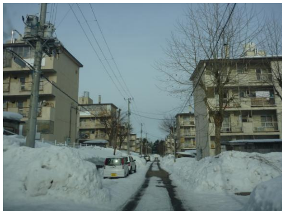
写真 25 K 団地の公営住宅
