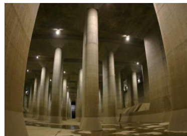
【首都圏外郭放水路の調圧水槽】
