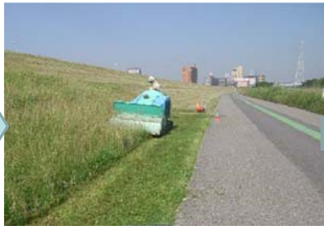
◆ 堤防点検等のため堤防除草を実施
