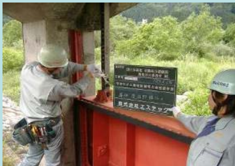
(樋管ゲートの点検)
