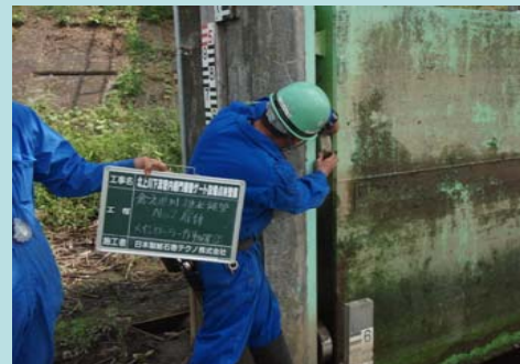
(ゲート設備の点検・整備)
