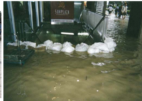
地下街への入り口に土嚢設置状況 (福岡市博多区)
