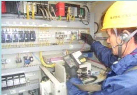
(機械設備の点検)
