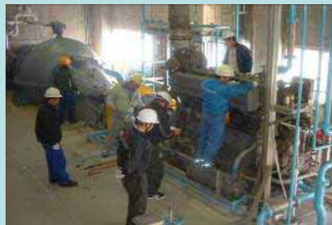
(エンジンの点検・整備)
