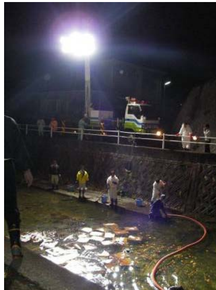
タンク操作ミスによる重油流出
