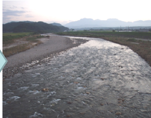
出水後の状況
