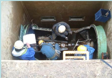
(ポンプ設備の点検・整備)
