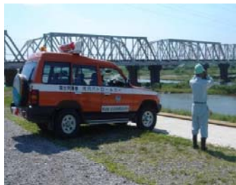
巡視車両による巡視
