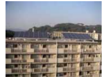
太陽光パネル
