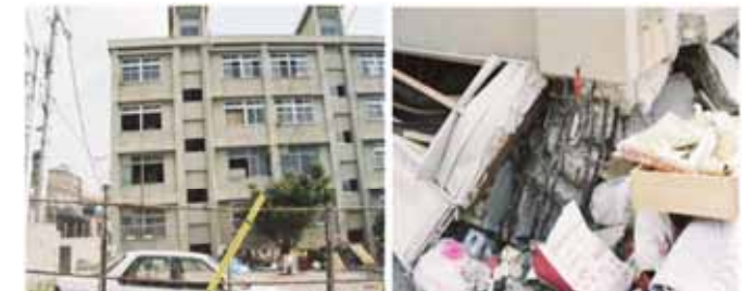
R C造・ラーメン構造(5階建)地震により1階部分が圧壊
