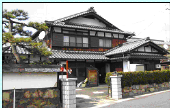
■ 伝統的な木造住宅(土壁・真壁) ■ 数寄屋 (大面積開口部)
