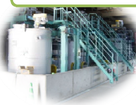
リン回収施設
