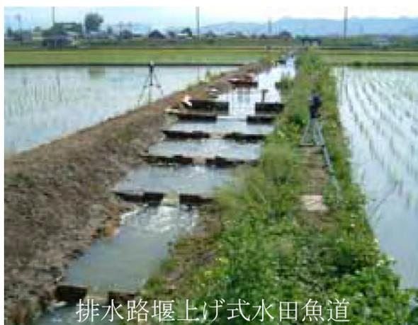
図3-3-2-3 排水路堰上げ式水田魚道の改良・設置
