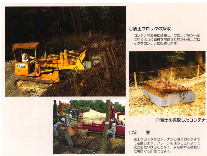
図 4-7 表土ブロックによる森林土壌の移植例
