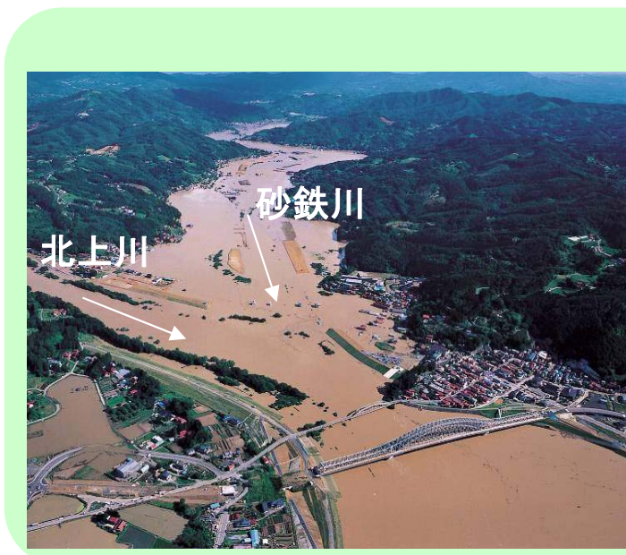
平成14年7月洪水 の被害状況
