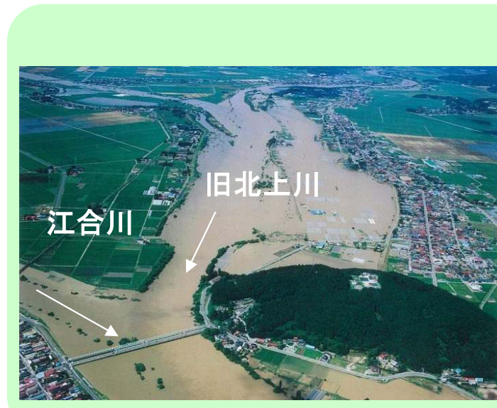
平成14年7月洪水 の被害状況
