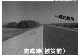
完成時(被災前)
