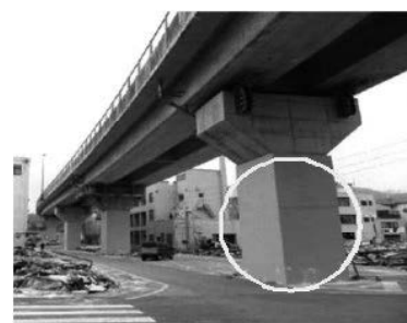
< 橋脚の耐震補強 >
