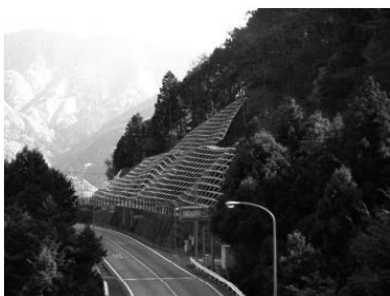
< 斜面崩落防止対策 >
