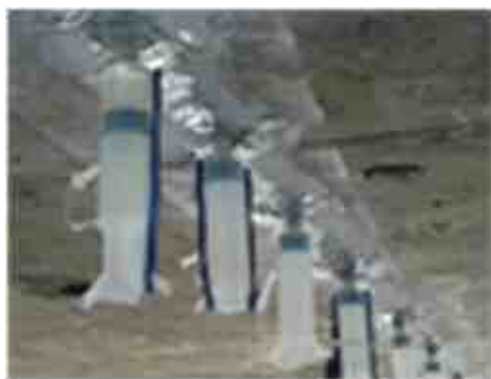
ひび割れ補修例(樹脂注入)
