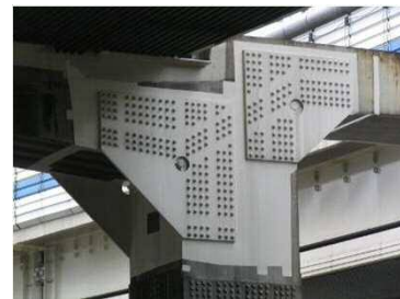
鋼製橋脚補強
