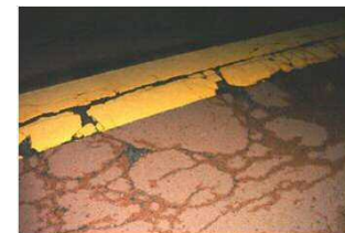
舗装のひび割れ
