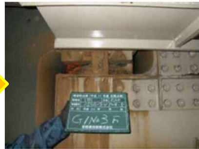
鋼箱桁密閉構造(外面)
