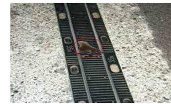
伸縮継手ゴムの破損
