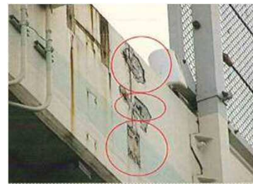
コンクリートの剥落
