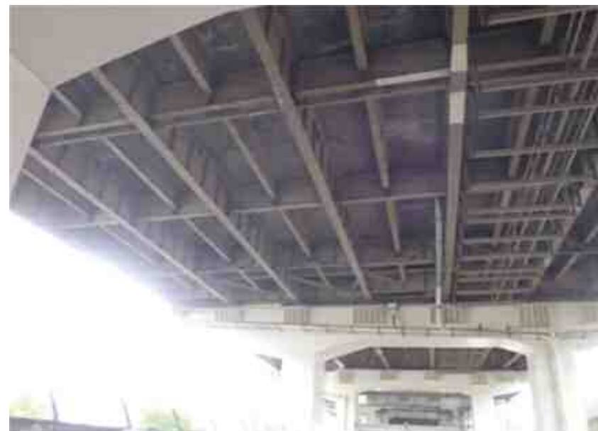
高架下から見上げた駒形付近床版裏状況
