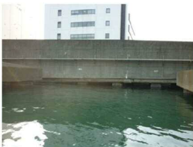
満潮時の栈橋構造(海面近接部)
