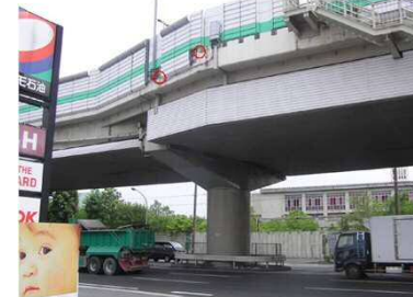
遮音壁、裏面板で覆われた橋梁
