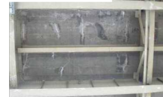
RC床板のひび割れ
