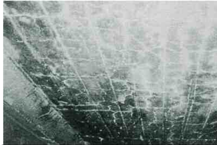
二方向ひび割れへの進展
