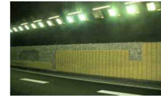
トンネルタイルの外れ
