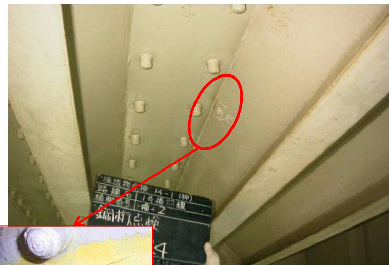
Yリブデッキ溶接部からのき裂損傷状況
