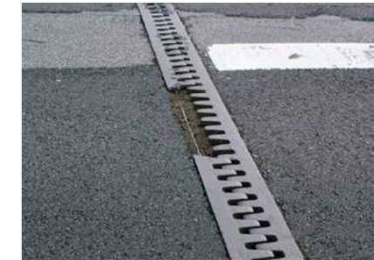
伸縮継手の損傷
