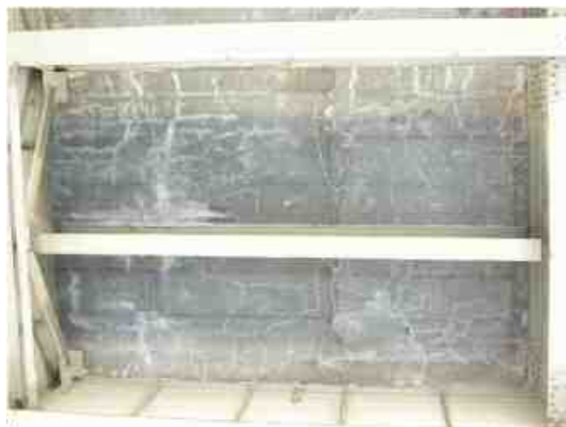
①コンクリートひび割れ(2方向)(向-250付近)
