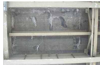
床板のひび割れ
