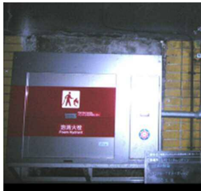
トンネル防災設備
