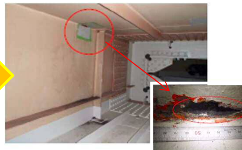
密閉構造直下の腐食状況
