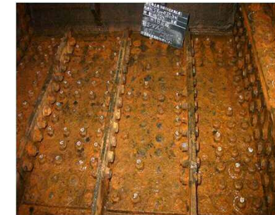
地中梁内の腐食状況
