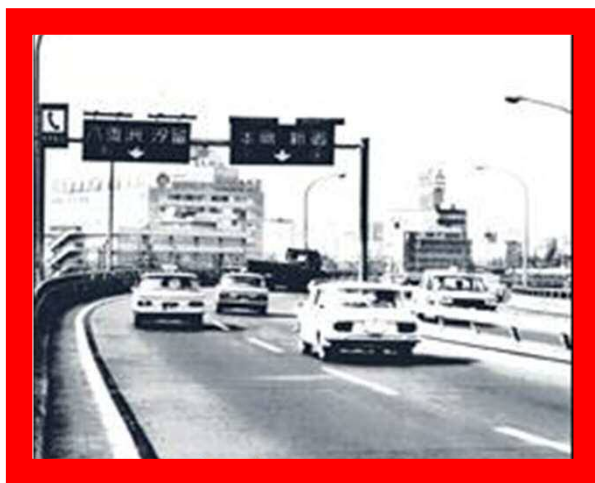
課題① 高齢化の進展、過酷な使用状況による損傷の増加
