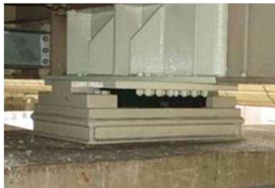
支承連結装置耐震性向上対策
