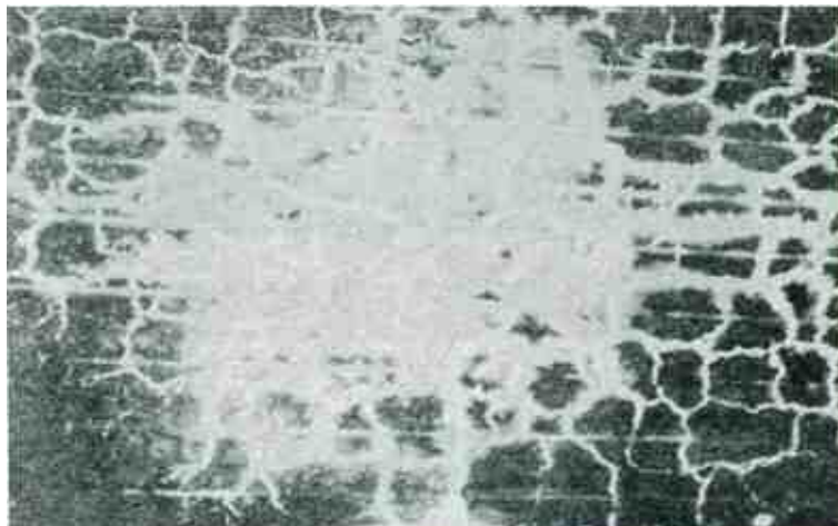
貫通ひび割れへの進展
