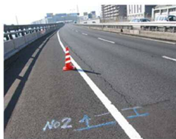
護岸埋立構造の路面ひび割れ
