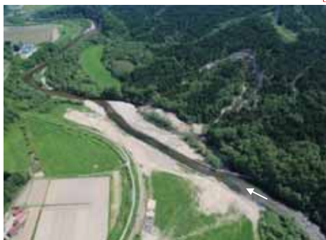
暫定断面による対応後の状況
