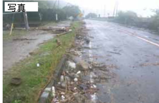
越波後の路面状況
