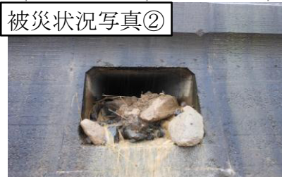
水路ボックス出口付近(海側)の状況
