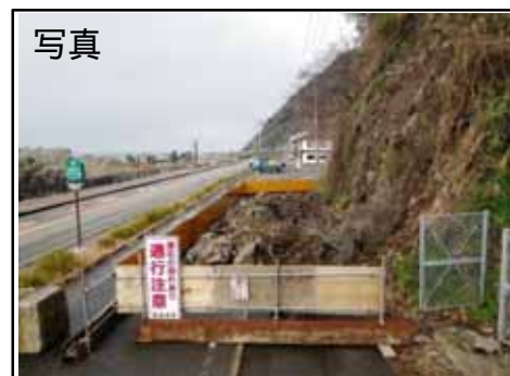
被災状況写真
