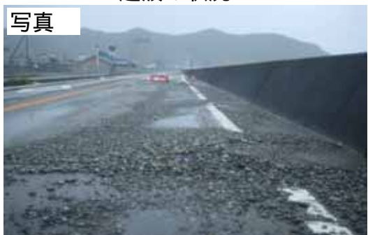
越波後の路面状況
