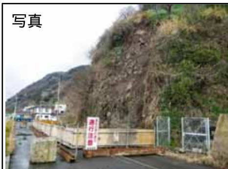
被災状況写真
