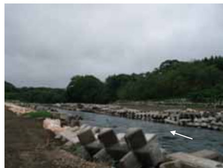
暫定断面による対応後の状況
