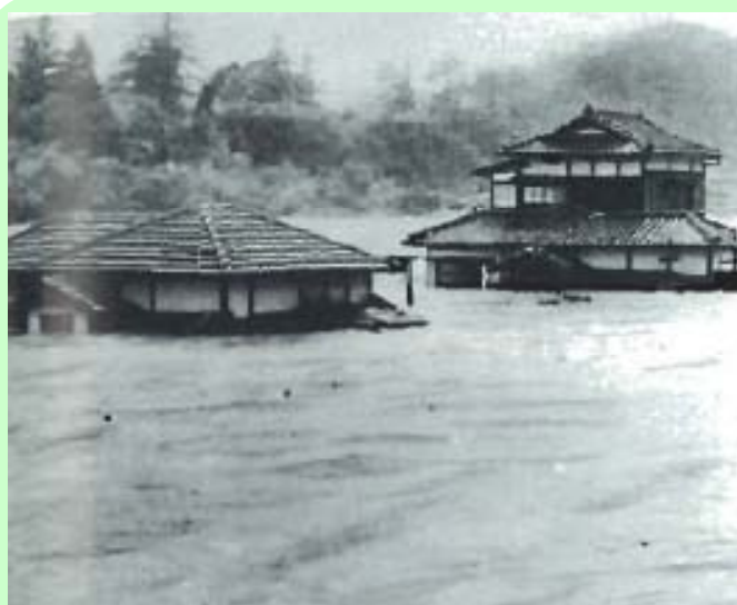
昭和25年8月洪水 (熱帯低気圧) の被害状況
