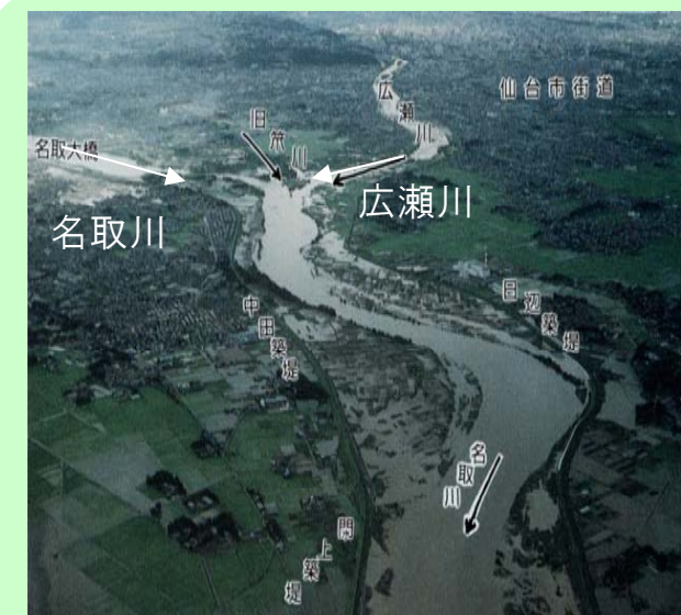
昭和61年8月洪水 の被害状況
