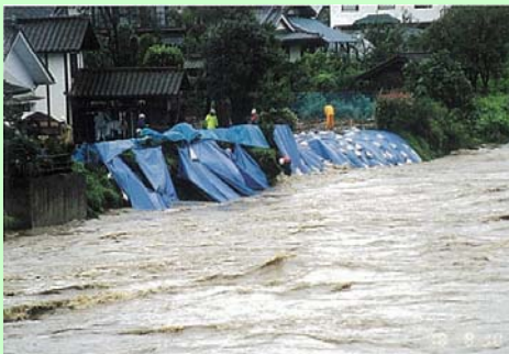
河岸崩壊の拡大を防ぐシート張り (福島県福島市)
