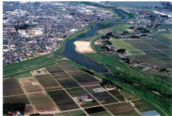
北上川合流点より 26.0km 付近の江合川 新江合川への分流地点。河川敷に市民公園が整備されており、冬に飛来した白鳥の餌付け場となっている。
