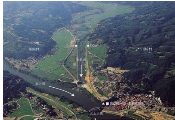
北上川合流点付近の砂鉄川 河川間際まで耕作地として利用され、河岸には河畔林がみられる
