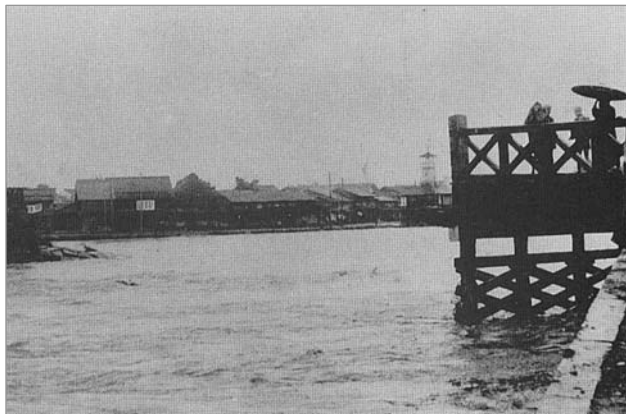
写真 明治 43 年洪水の被害状況
