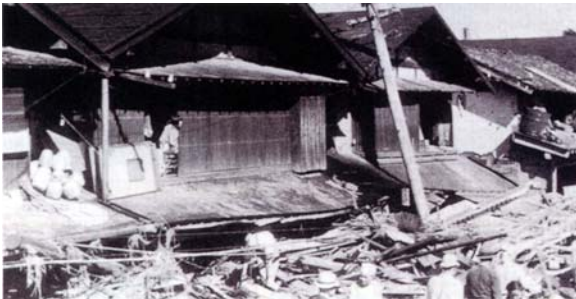
写真 カスリン台風の被害状況（一関市大町街路）
