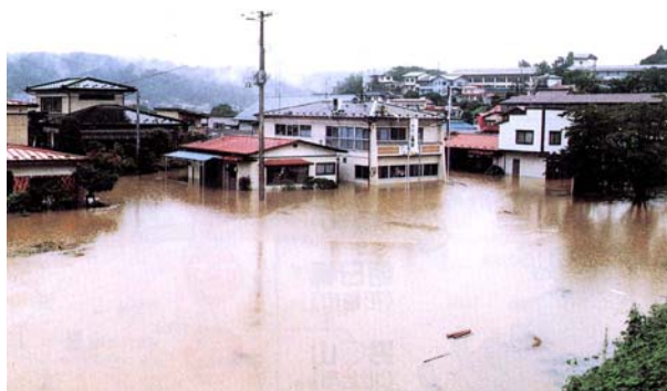
写真 平成 10 年の被害状況 (一関市川崎町)
