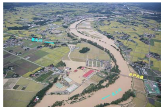
写真 平成 19 年の被害状況 (花巻市井戸向橋付近)
