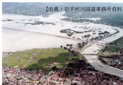
写真 昭和 56 年の被害状況 (一関市)
