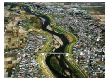
下流部/北上川下流河川事務所
