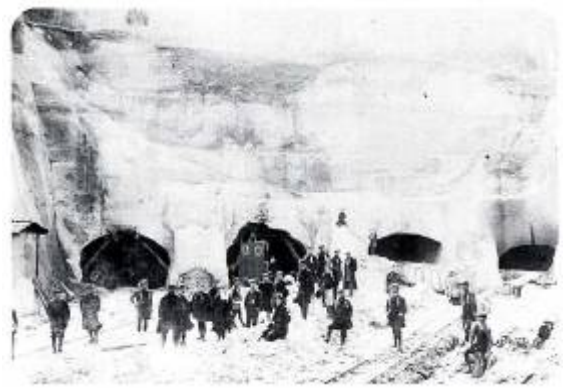
明治潜穴開削の様子 （北上川下流河川事務所）
