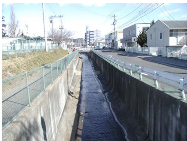
▲現在の木流堀 現在はコンクリート張りの水路に改修され、当時の面影は無くなっている
