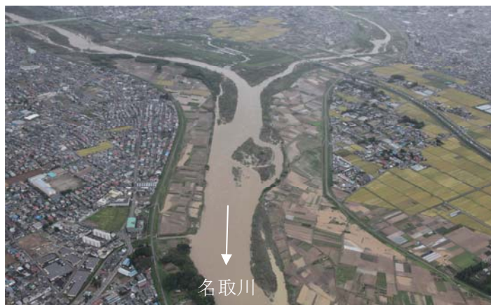
▲平成23年9月洪水 (名取川と広瀬川の合流点付近) 【出典：仙台海川国道事務所資料】
