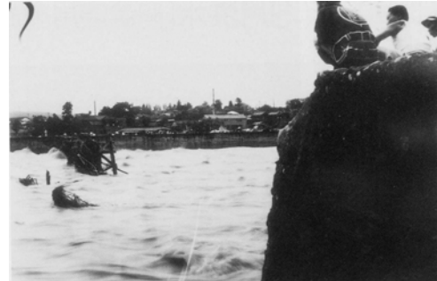
▲昭和 25 年 8 月洪水(評定河原橋の流出) 【出典：仙台河川国道事務所資料】
