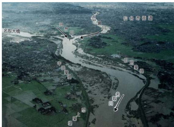
▲昭和 61 年 8 月洪水 (広瀬川合流点付近の氾濫と浸水状況) 【出典：仙台河川国道事務所資料】
