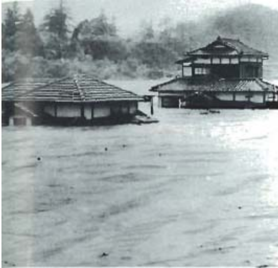
▲昭和 25 年 8 月洪水 (広瀬川堰場付近で洪水に吞まれようとする住宅) 【出典：仙台河川国道事務所資料】
