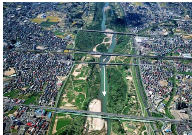
▲名取川8.0km～9.0km付近の状況 【出典：仙台海川国道事務所資料】
