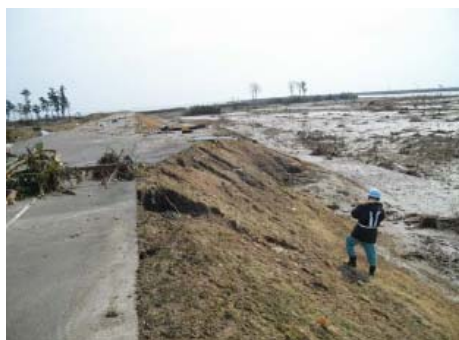
名取川左岸 0.3k 付近 (仙台市若林区日辺地先) ※津波により堤防法面侵食
