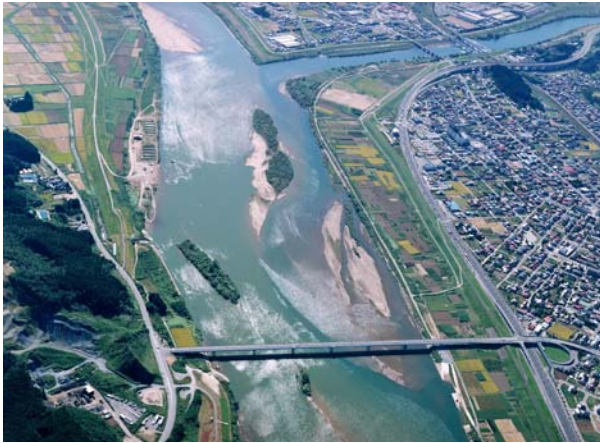
砂州を形成しながら蛇行する 【出典：仙台河川国道事務所 資料】
