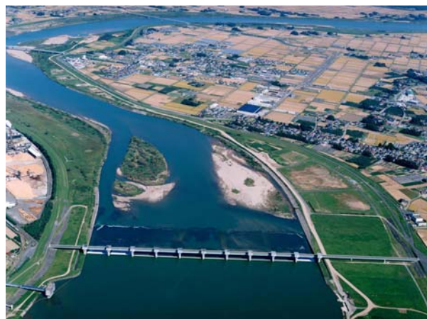
代表的な河川構造物 阿武隈川大堰
