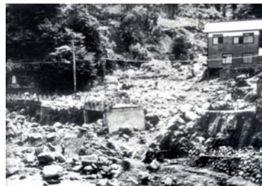
荒川右支川東鴉川の土石流被害
