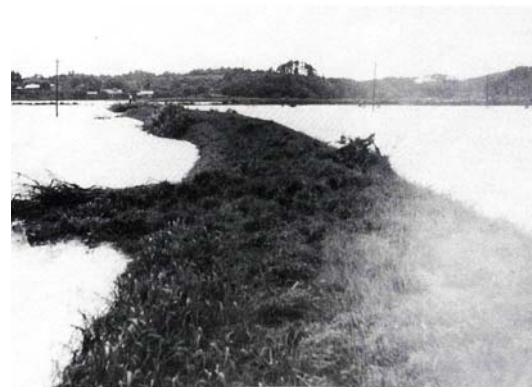
千島列島の浸水状況（7月4日）（福島県事務所）
