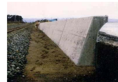
護岸壁の一例
