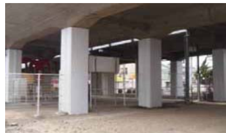
高架橋の柱に鋼板を巻いた耐震補強の実施例
