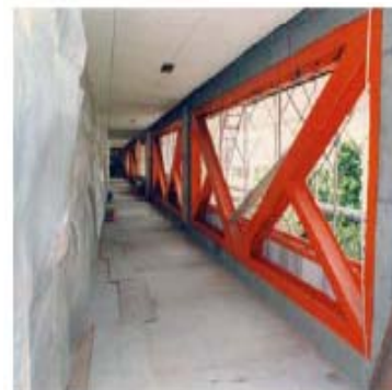
鉄骨ブレースによる壁の補強
