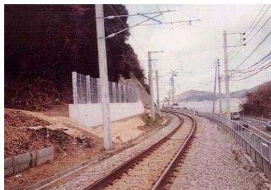
落石防止擁壁の一例
