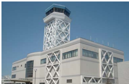
管制塔等の倒壊防止
