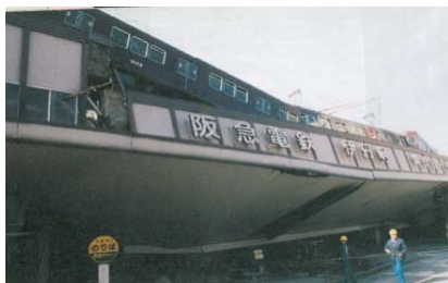
阪神大震災で高架の倒壊とともに崩落した駅(阪急電鉄 伊丹駅)
