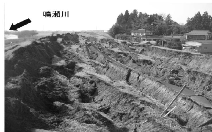
堤防の被災状況 (鳴瀬川 左岸30.0k~30.5k+37m付近の被災)
