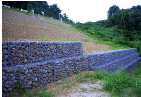
<盛土のり尻補強>
