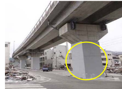
<橋脚の耐震補強>
