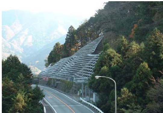
<斜面崩落防止対策>
