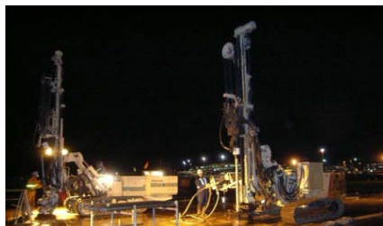
地盤改良により基本施設等の液状化を防止
