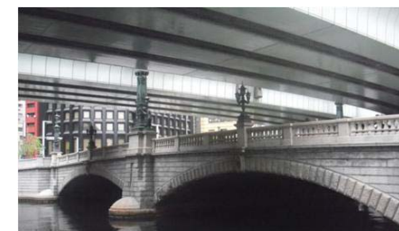
▲上空を首都高速に覆われた日本橋
