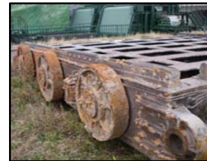
老朽化した水門のゲート
