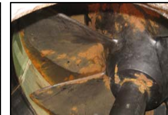
老朽化した排水ポンプのインペラ
