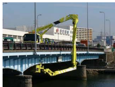
▲橋梁点検車による点検
