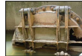
老朽化した排水機場の逆流防止弁
