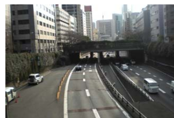
▲走行車線間に橋脚が立つ亀井橋
