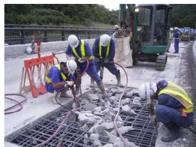
▲床版の打ち換え
