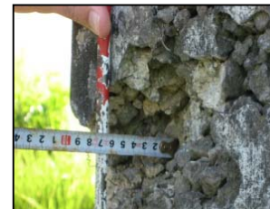
老朽化した樋門の門柱
