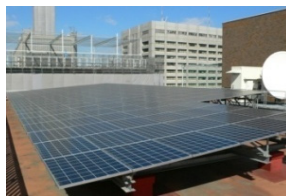
太陽光発電システム
