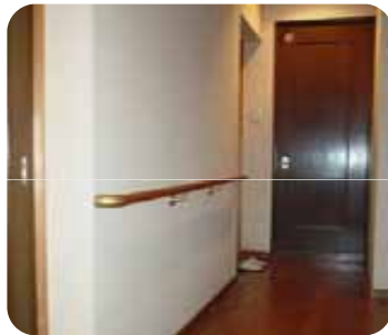
手すりの設置
