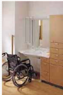
水廻り設備の改修 (洗面台)
