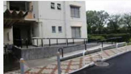
スロープの設置
