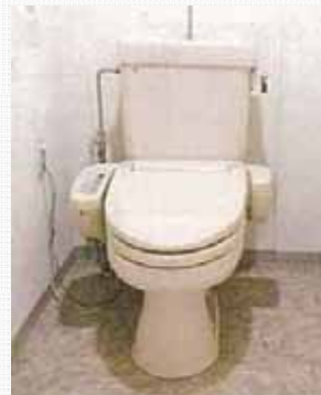
水廻り設備の改修 (トイレ)
