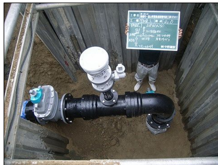
緊急連絡管の接続箇所(基山町側)
