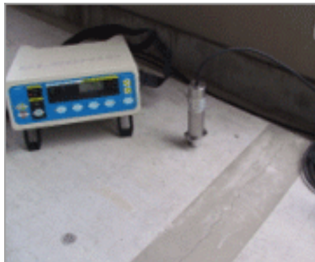
ひび割れ深さの調査例 (超音波法)
