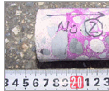
中性化深さの測定例 (フェノールフタレイン法)
