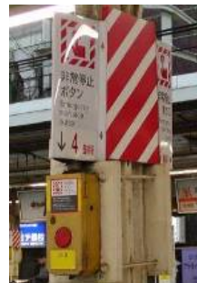
図3: 非常停止押しボタン
