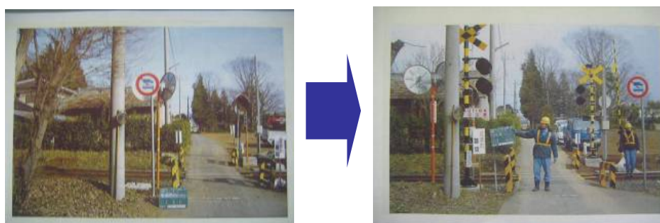
図1：踏切遮断機・警報機の整備
