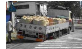
下水道管渠に起因する路面陥没
