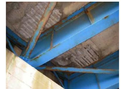
・C判定(剥離・鉄筋露出)
