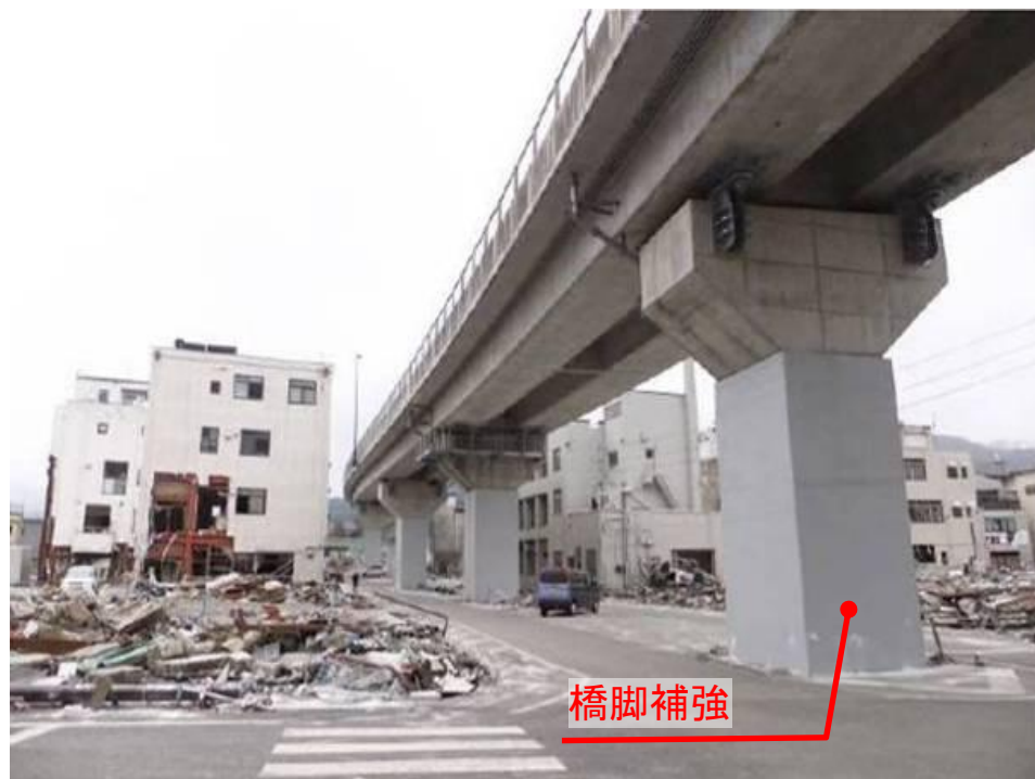
国道45号（観測震度：震度6弱）
