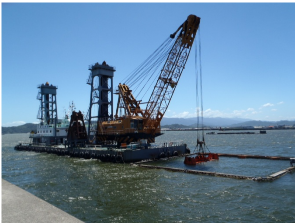
グラブ浚渫船による浚渫状況
