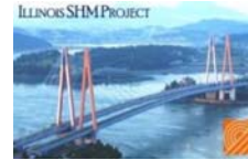
対象とする橋梁
