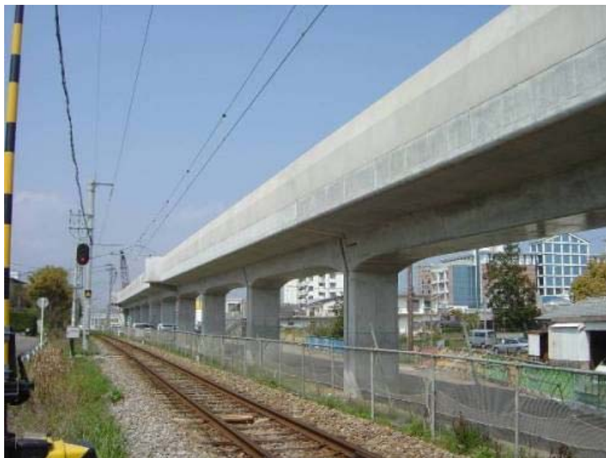
一柱タイプ 15mスパンで整備した高架構造物
