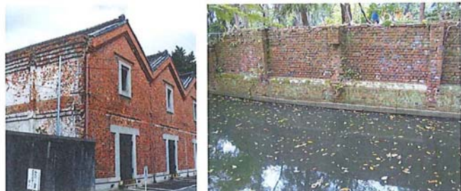
諸戸邸の煉瓦倉庫と煉瓦造の導水路
