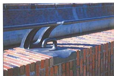
地場の鋳物を用いた係船金具と手すり
