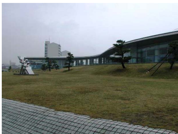
法面勾配の変化と松の植樹
