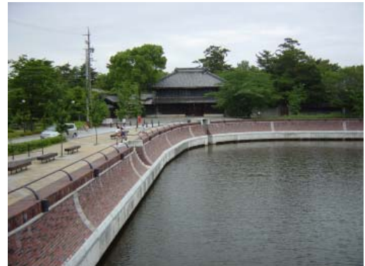
コンクリート護岸を煉瓦で修景
