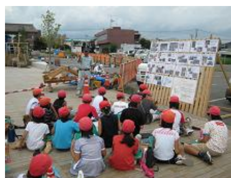
小学生による現場見学会
