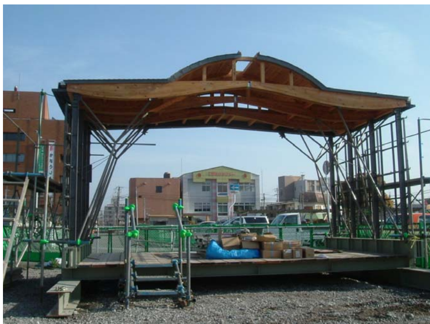
施工段階における 1/3 スケールモックアップ
