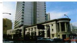
歴史的建造物の保存修復 (横浜市北仲通り南地区)
