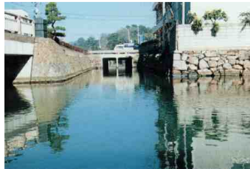
下水道整備進捗後の松江堀川(整備後)
