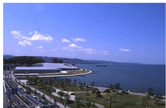
公園と美術館が一体的に整備された例 公園の芝生広場に美術館の作品を展示している。 (岸公園:松江市)
