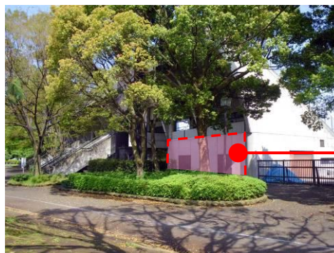
野球場スタンド下の備蓄倉庫の前面が植栽で修景されている。(平塚総合公園：神奈川県)
