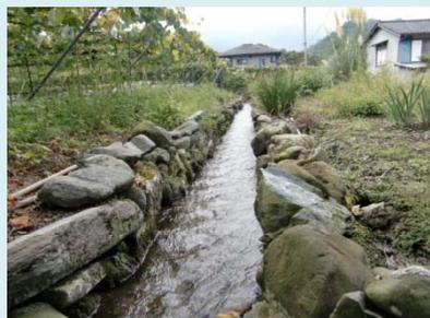
町の中心である小幡地区内を網の目のように流れている雄川堰は、現存する水路ネットワークや石積みなど、昔からの形態が良好に残されている。しかし一部の区間はコンクリート側溝に置き換わり、また民地内の区間では、現状で管理されていないケースもある。そこで本調査では、雄川堰の水路形状や流量、保存状態等に関する悉皆調査を実施するとともに、地域住民と有識者によるワークショップを開催し、雄川堰の保存・活用に向けての方策を検討する。さらに石積みの検証的補修を行い、雄川堰の歴史的価値や石積み補修の方法・手順等を紹介するガイドブックを作成する。
